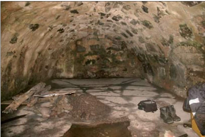
Fig 5. Källarens insida. I bildens nedre del syns en del av den provruta som togs upp i källaren. Foto Åsa Berger. SSLM bild Lp20070088.
